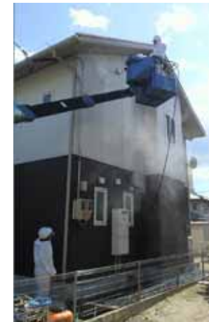
福島市渡利地区の除染の様子
