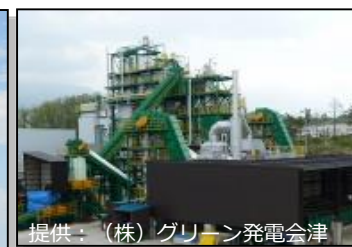
○木質バイオマス発電所
