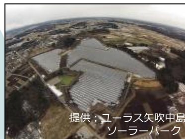
○メガソーラー発電所
