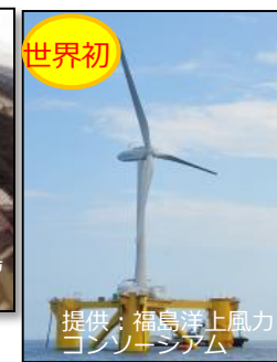
○浮体式洋上風力発電設備「ふくしま未来」
