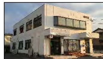
【店舗再開】 富岡支店・大熊支店 (2017年4月6日)
