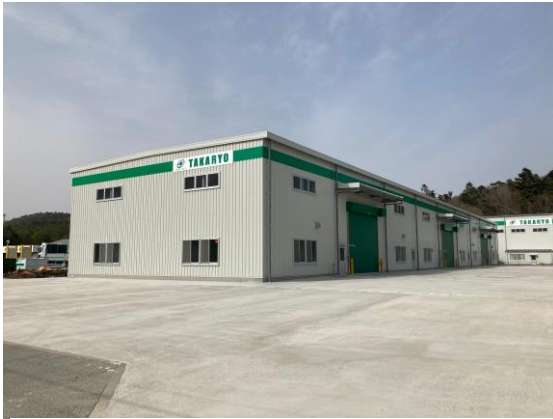
■ 太陽光パネルリサイクル設備(建物外観)
