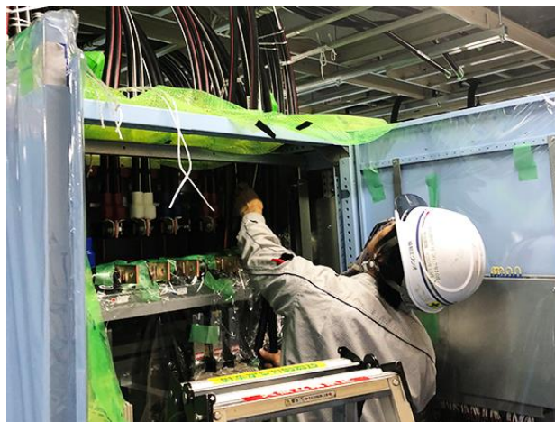
【電気通信設備工事の様子】
